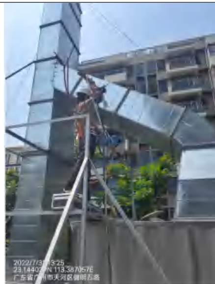
垃圾收集站有组织臭气监测
