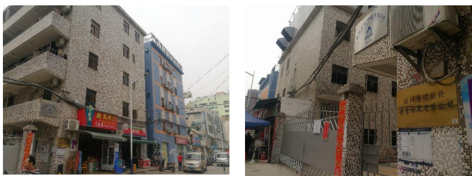
图 3-4 深圳市伟创发实业发展有限公司现场情况
