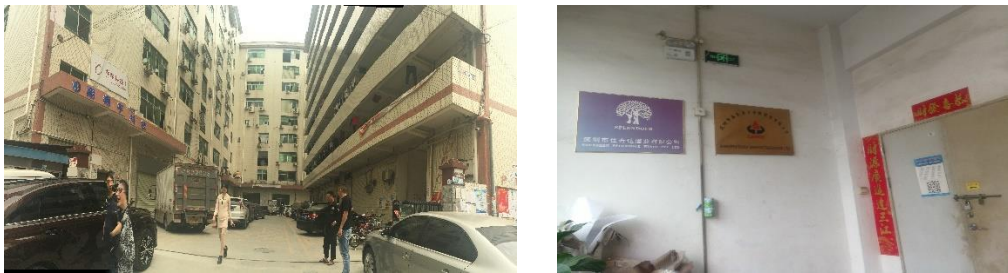
图 3-8 深圳市泰豪源不干胶有限公司现场情况
