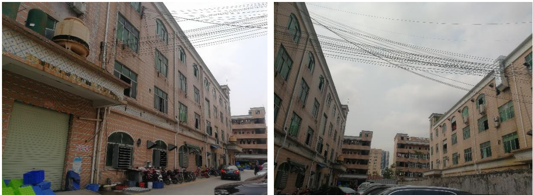
图 3-12 深圳市威雅莉科技有限公司现场情况
